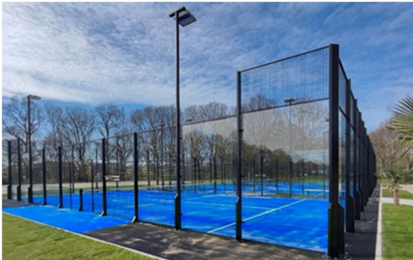
Padelbahn auf einem SuperSub® Fundament
